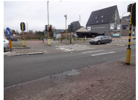
Ontbrekende wegmarkering oversteekplaats fietsers op N14
