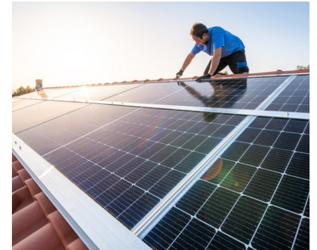
Foto: Instalando paneles solares – Eloi Omella – iStock
